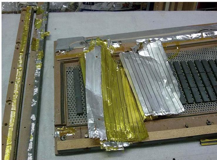
Mit dem Schaber entfernen Sie auch die alten Schaumstoffreste welche sich umlaufend an der Holzrahmen befinden. Auch die Oberteile der Rahmen müssen gründlich gereinigt werden.
