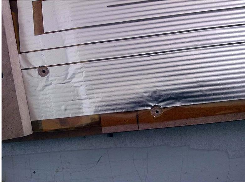
Jetzt verwenden Sie das doppelseitige Klebeband und fixieren die Anschlußpads oben und unten auf dem Holzträger. Danach schrauben Sie das Seitenteil mit etwas Silikon wieder auf die Folie.
